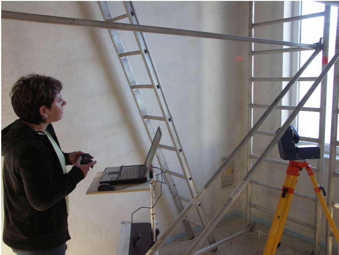
Ermittlung des Wandverlaufs und des Deckenlochs mit Flexijet
