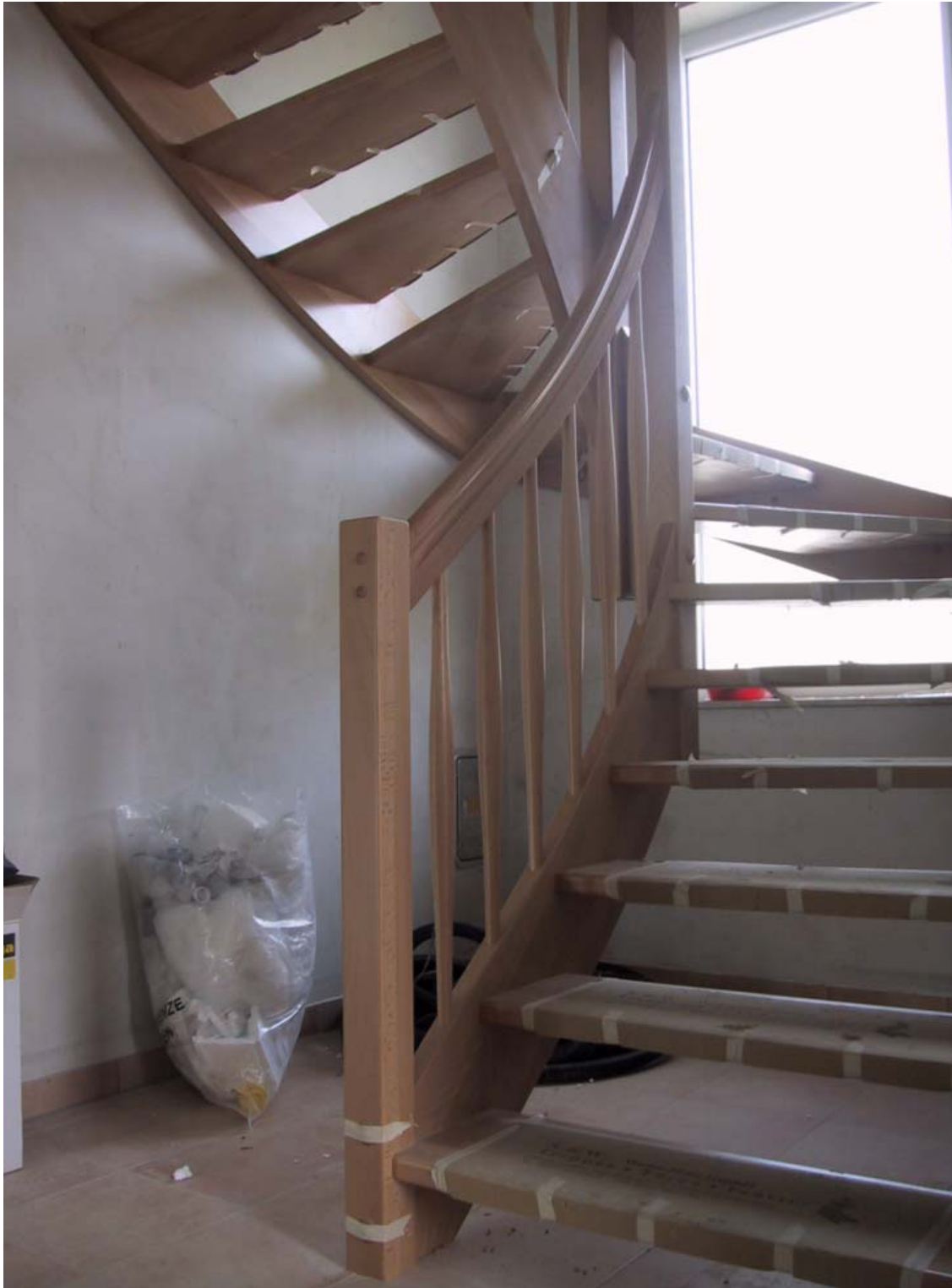
Die fertig montierte Treppe
